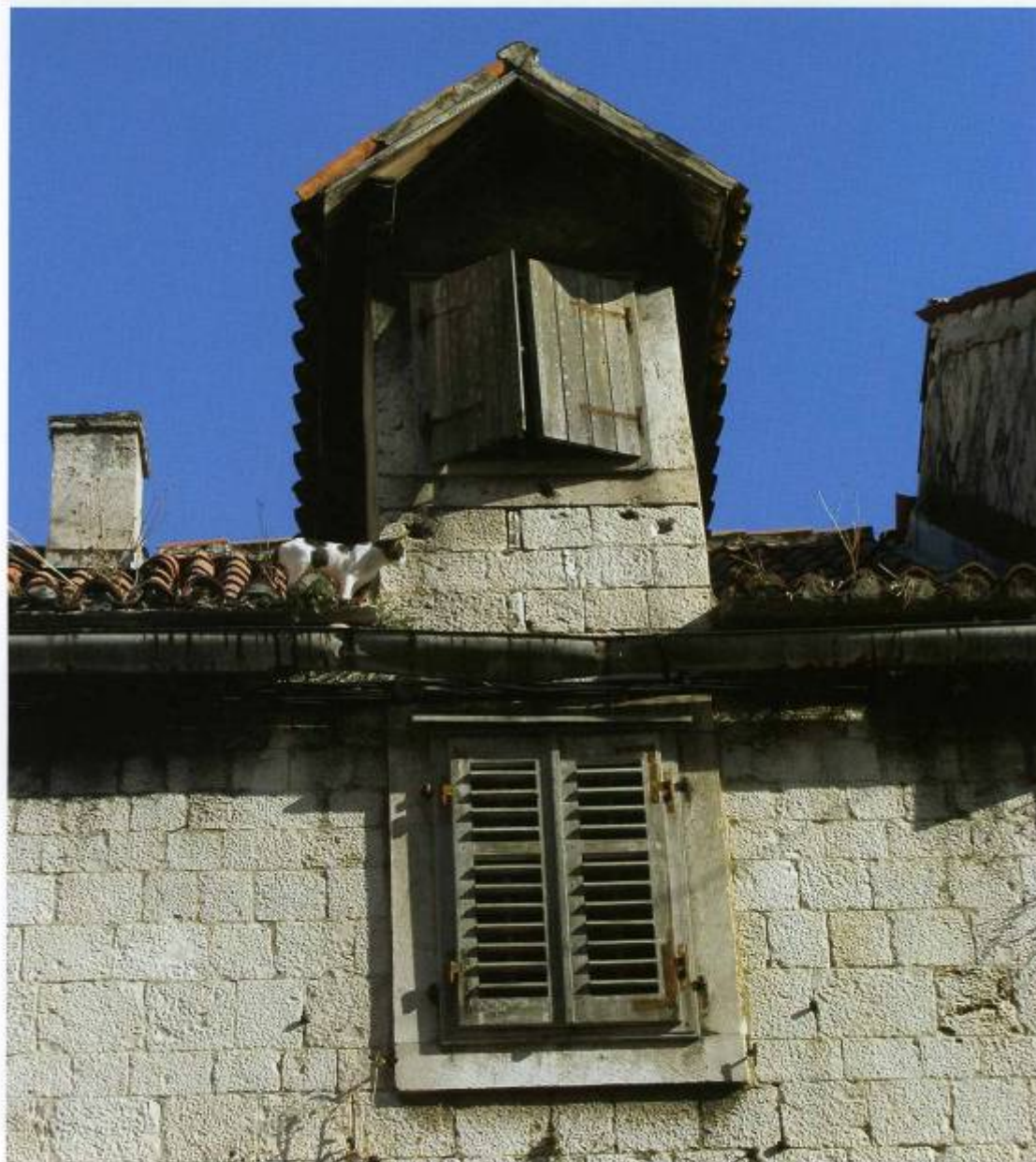
Luminar s parapetom u ravni pročelja.
