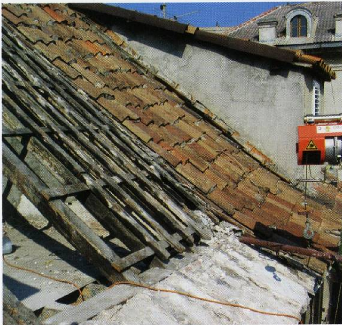
Polaganje kupe kanalice preko dvostrukog letvanja. Spoj krova i susjednog zida pokriven je nizom donjih kupa.
